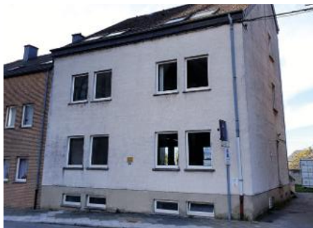
A Salle paroissiale Saint-Martin: Rue Jean Koch 17 à Arlon
